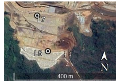
Figura 22: Localização das lamina no talude.
