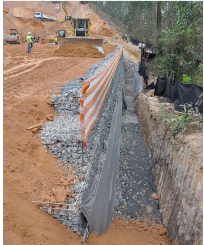
Figura 7. Construcción primeras capas del muro
