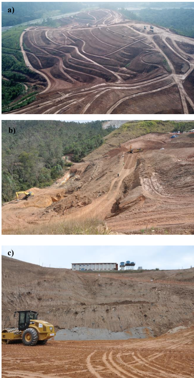
Figura 6. a) Estado inicial b) Preparación del terreno y c) compactación
