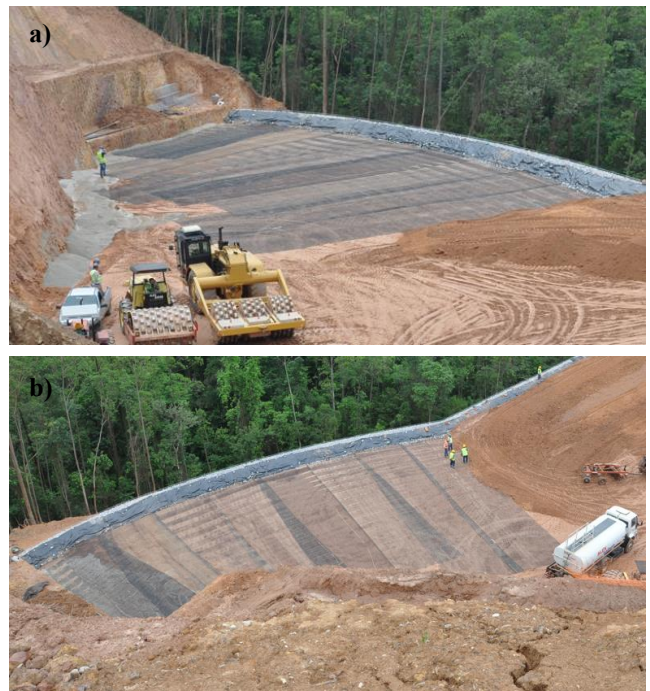
Figura 8. Posicionamiento de geomallas a) vista lateral b) vista superior
