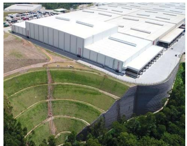
Figura 12. Vista dron – Construcción finalizada
