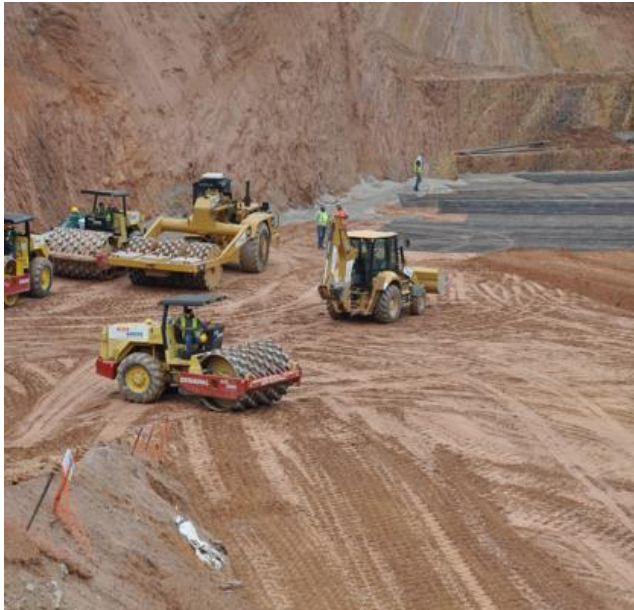
Figura 9. Compactación del relleno
