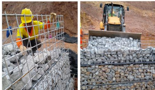
Figura 9. Compactación del relleno
