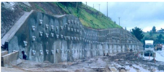
Figura 1. Construcción de muro anclado en acceso Sur del Viaducto Malleco (Pilotes Terratest, 2020).
