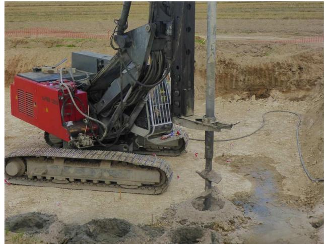
Figure 3. Ejecución de columnas de Soil Mixing para el proyecto Ilza Wind Farm II en Polonia.
