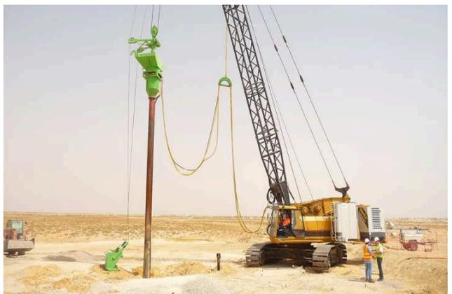
Figure 5. Ejecución de Vibro-Compactación y Columnas de Grava para el proyecto Nouakchott en Mauritania.
