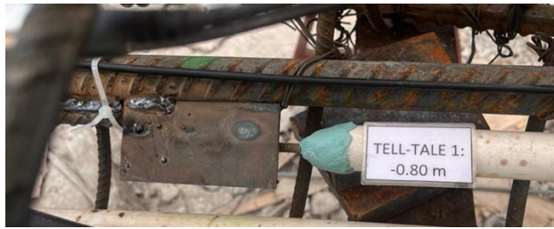
Figura 14. Colocación de tell-tales en micropilote.
