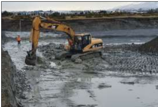
Figura 8. Excavadora a nivel de sello de excavación.
