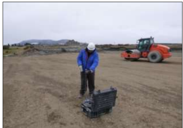
Figura 10. Relleno finalizado y control de compactación mediante ensayo PANDA®.
