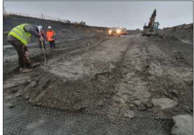
Figura 9. Ejecución primera capa de relleno arenoso sobre geomalla.
