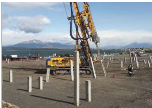
Figura 16. Pilotera hincado pilotes de hormigón de sección cuadrada.
