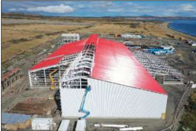
Figura 20. Vista de la Planta Industrial en fase de montaje.
