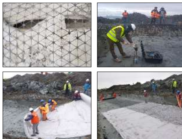
Figura 3. Ejecución de canchas de pruebas.
