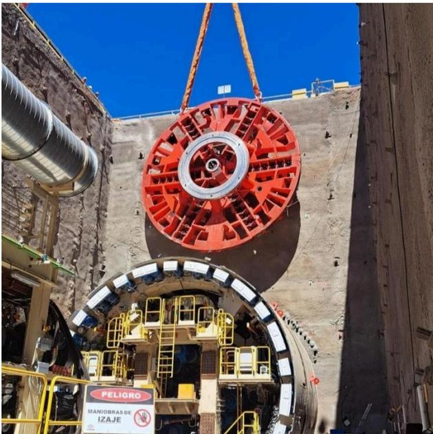
Figura 16. Montaje de la rueda de corte al escudo de la tuneladora (marzo 2024)
