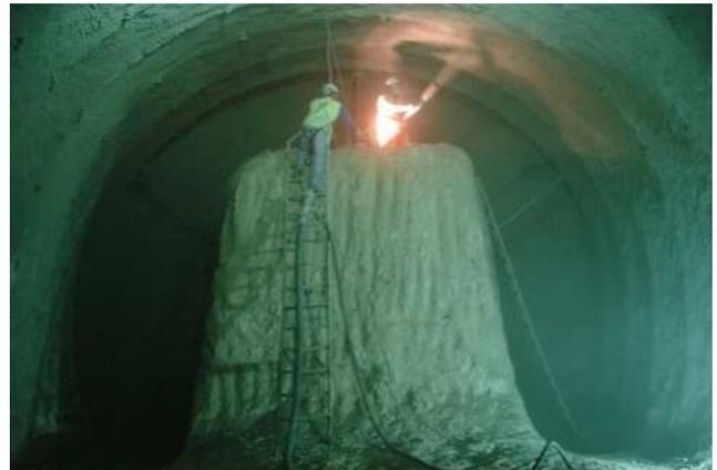
Figura 4. Excavación de túneles interestación del Metro de Santiago durante la tercera etapa (2001-2011; L4, Ext L5, Ext L2 y Ext L1)
