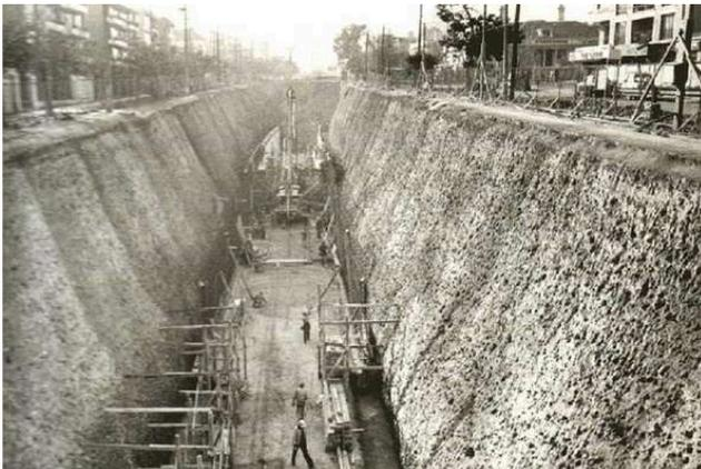
Figura 2. Excavación de túneles interestación del Metro de Santiago durante la primera etapa (1969-1987; L1 y L2)
