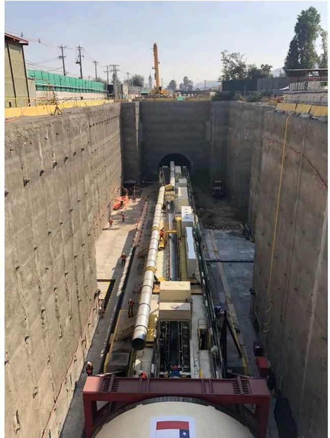
Figura 18. Estructura de arrastre de la tuneladora al momento de inicio de sus operaciones (mayo 2024)
