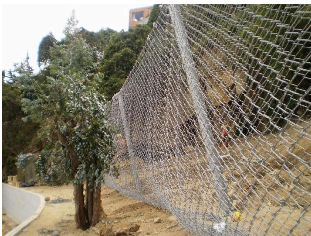
Figura 10. Integración de sistemas flexibles mediante barreras dinámicas junto con medidas de control en antigua cantera (Fuente: elaboración propia)
