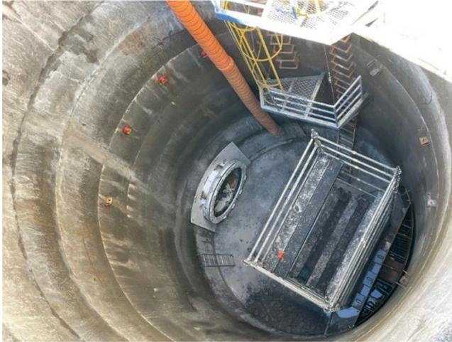
Figura 3b. Pozos de trabajo, lanzamiento y recepción en fase constructiva.
