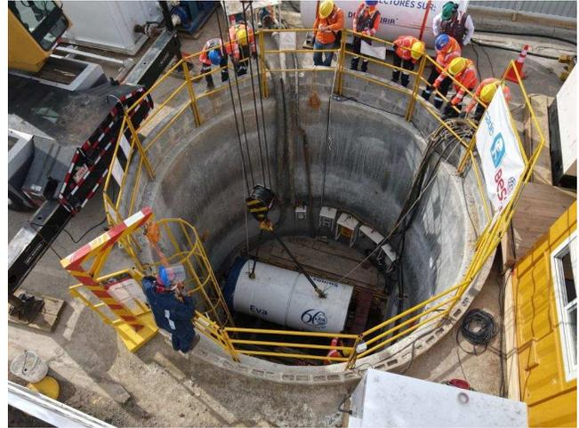
Figura 4b. Descenso de microtuneladora al pozo de lanzamiento.
