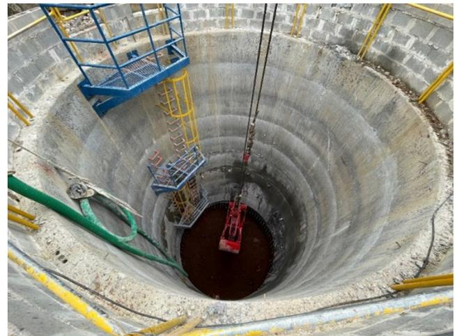
Figura 3a. Pozos de trabajo, lanzamiento y recepción en fase constructiva.
