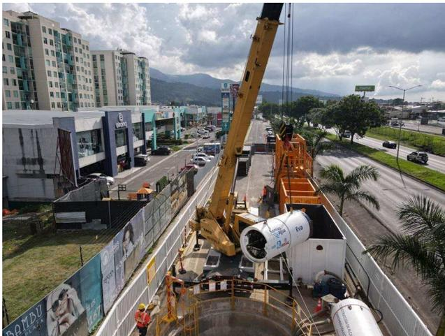
Figura 4a. Descenso de microtuneladora al pozo de lanzamiento.
