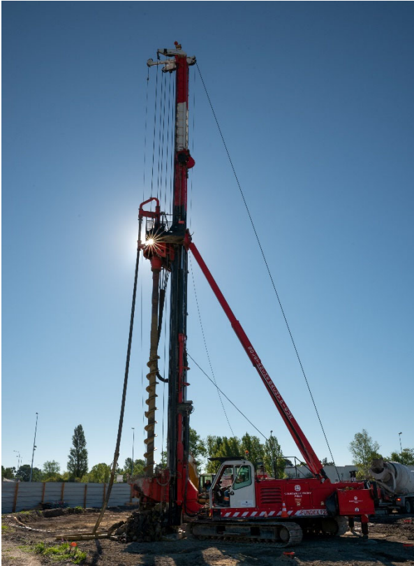
Figura 8. Construcción de pilas T-PILE®. Paralelo 45 Merignac.
