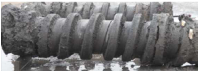
Figura 7. Tramos exhumados de una T-PILE® de desplazamiento.
