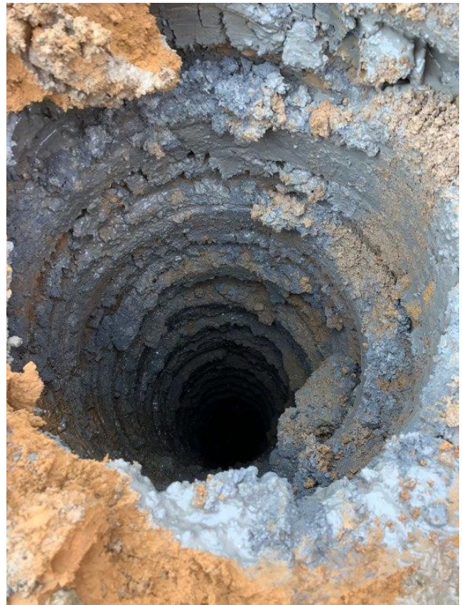
Figura 10. Perforación de prueba en los materiales de relleno.
