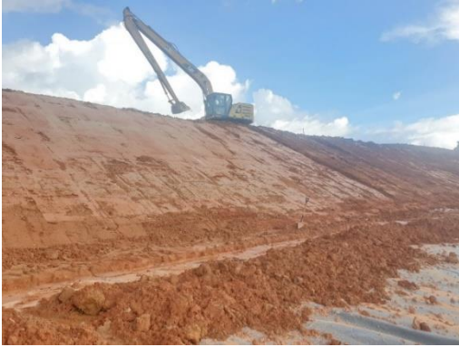
Imagen 6. Textura del sapolito con cemento antes de la colocación de geomembrana. Nota: La textura del relleno parece ser de baja permeabilidad.
