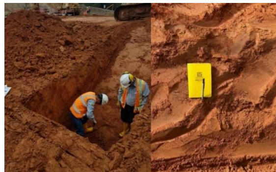
Imagen 4. Ensayos de resistencia simple dentro de calicatas en el núcleo. Fotos tomadas en el Dique de Arranque
