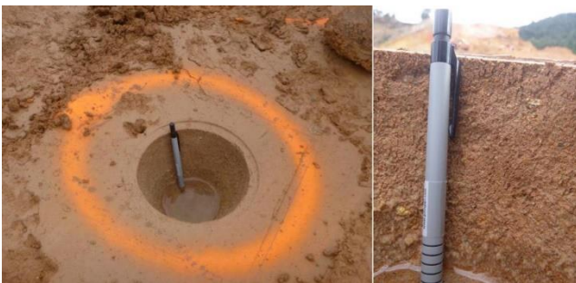
Imagen 7. Textura del sapolito con cemento dentro de un ensayo de cono de arena. Nota: El agua de la foto se debe a precipitaciones. La textura del relleno parece ser de baja permeabilidad. Foto tomada en junio 2019.
