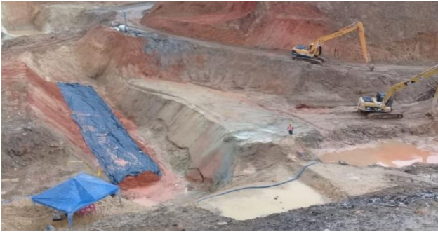
Imagen 2. Colocación y compactación del sapolito sin cemento en la zanja de corte. Nota: El material es protegido con plástico para evitar su saturación. Foto tomada en diciembre, 2018.
