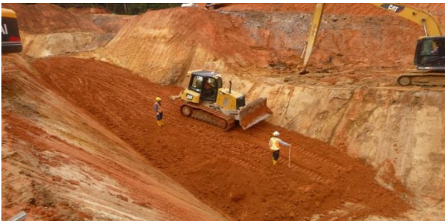
Imagen 3. Colocación y compactación del sapolito con cemento mezclado en el área de préstamo colocado en la zanja de corte. Foto tomada en enero, 2019.
