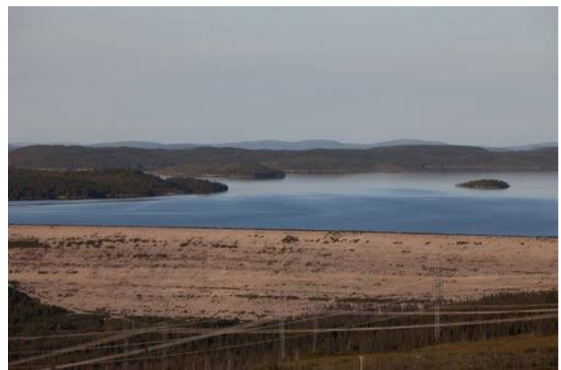
Fig.8. La Grande 4 (LG4) Main Dam, Québec
