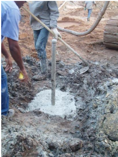
Figura 5. Tubo de acero galvanizado insertado en el pilote.
