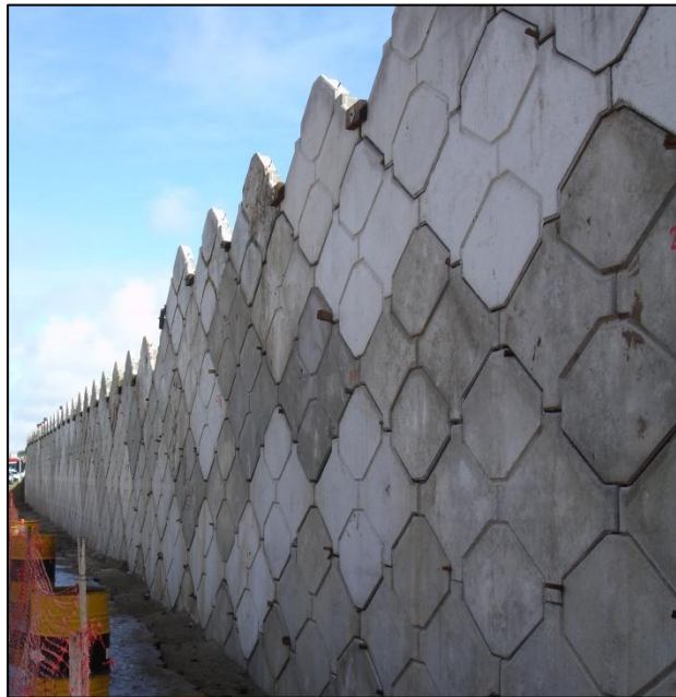
Figura 4. Muro de tierra reforzada en construcción (São Paulo, Brasil).
