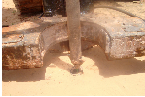
Figura 1. Tubo de refuerzo auto-perforante para pilote Anker
