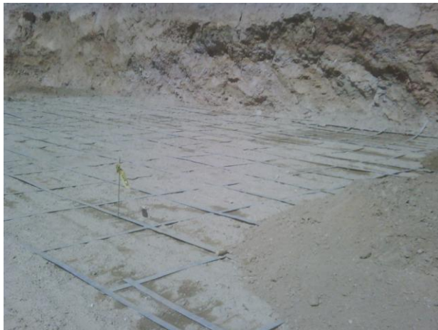
Figura 6. Construcción de refuerzo con pletinas entrecruzadas por soporte del muro superior.
