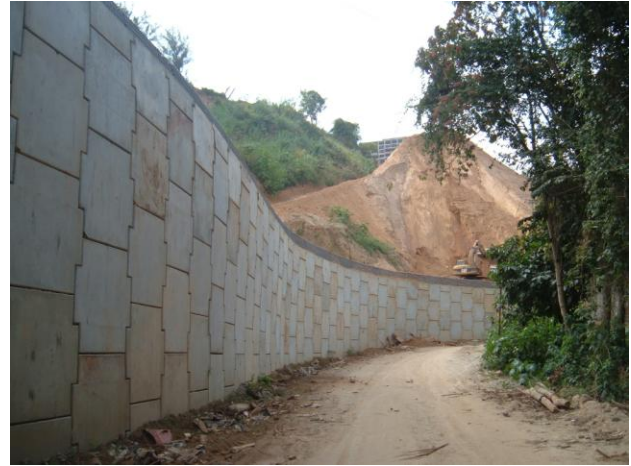
Figura 9. Muro Inferior en construcción.
