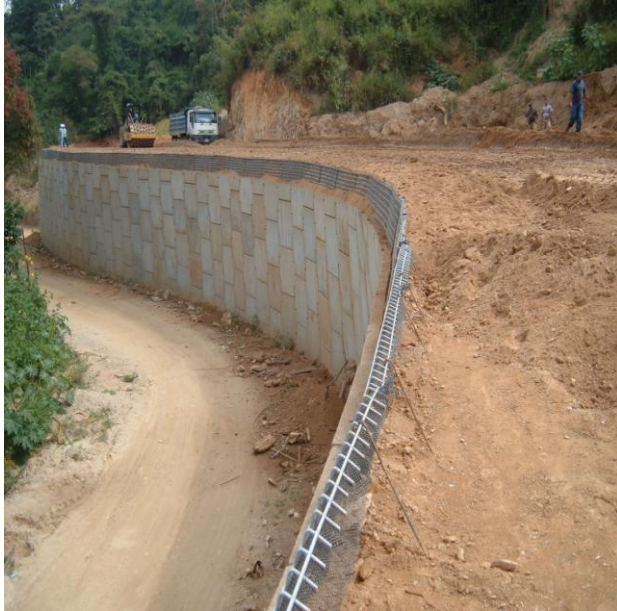
Figura 10. Muro Inferior en Construcción.
