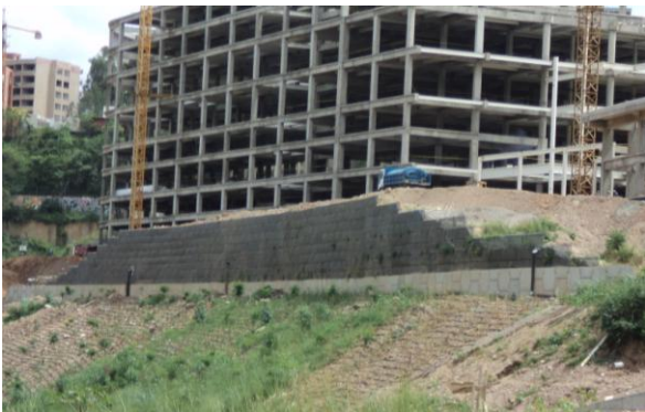
Figura 8. Muro Superior en construcción.
