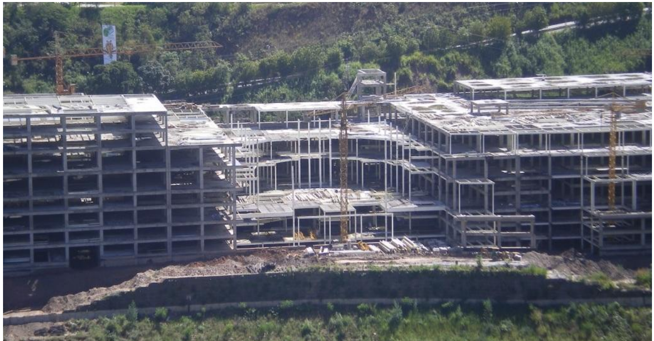
Figura 1. Vista general del muro superior y la edificación.
