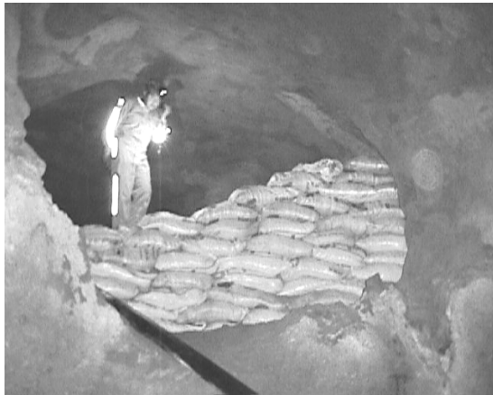
Figura 9. Relleno de una cavidad con costales de arena en la colonia Lomas Lindas en el Municipio de Atizapán de Zaragoza, Edo. Méx.
