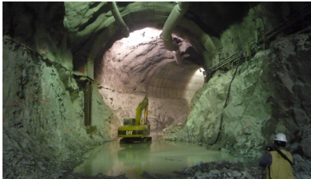
Figura 7.1 Excavación del Túnel de Desfogue
