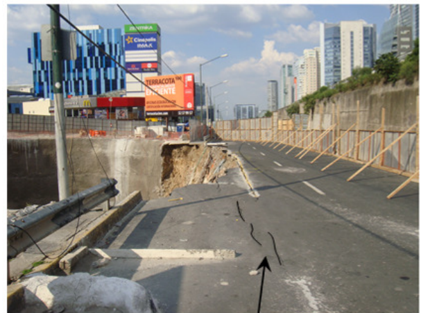
Agrietamiento incipiente
