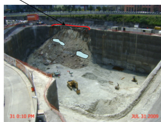
Figura 9 Sobreposición de las bolsas o caídos previos sobre el deslizamiento general.
