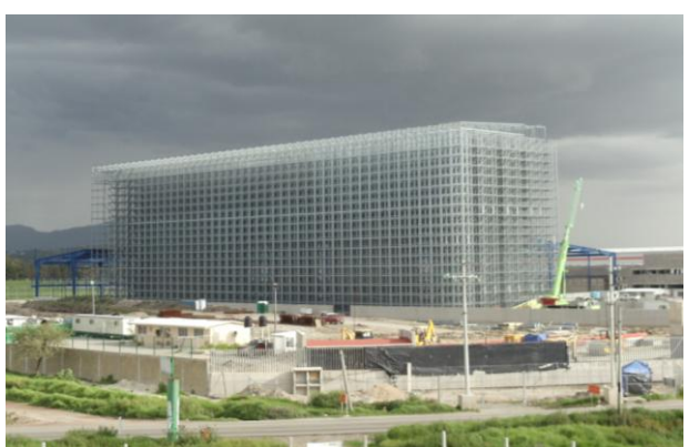
Avance constructivo de la nave automatizada hasta agosto de 2010
