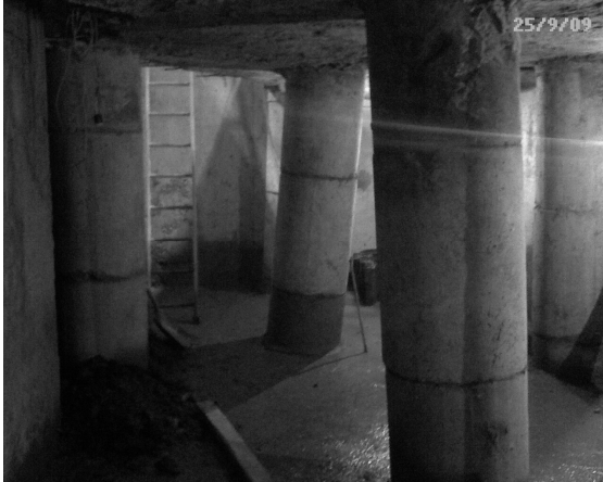
Figura 7. Vista bajo zapata tipo z-2 con el cajón terminado
