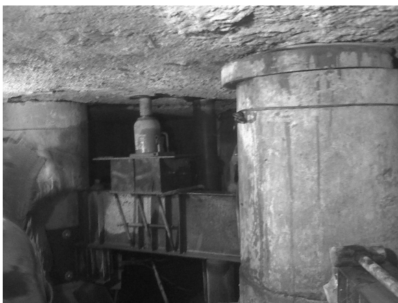
Figura 13. Se aprecia las vigas de acero soportando las cargas del edificio a través de los gatos hidráulicos
