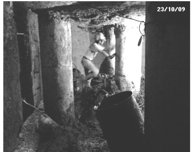
Figura 5. Excavación bajo las zapatas
