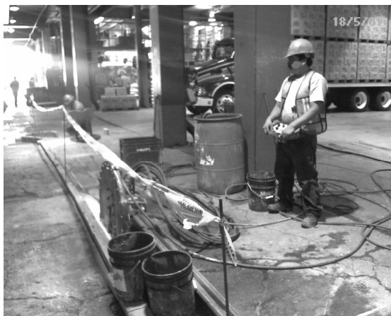
Figura 3. Corte con disco en pisos
