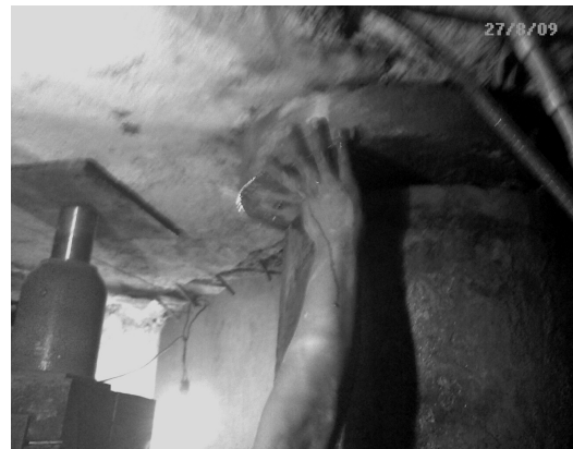
Figura 15. En esta imagen se aprecia la extracción del segmento de pilote cortado
