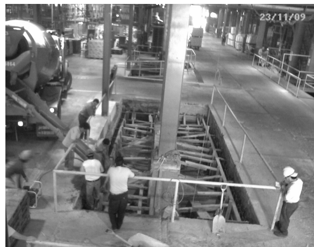
Figura 5. Excavación bajo las zapatas
