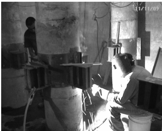
Figura 12. Montaje de anillos y ménsulas en pilotes, por debajo de la zona de pilote a cortar.
