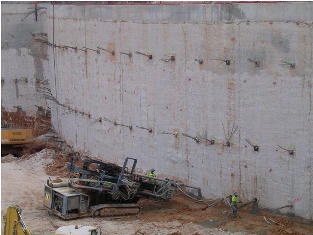
Figura 10. Ejecución de anclajes en el Corte Ingles de Albacete.
