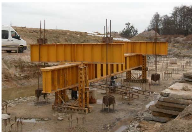
Figura 1. Ensayo de carga estática con gato instalado bajo vigas de lastre soldadas a 4 pilotes apartados.
