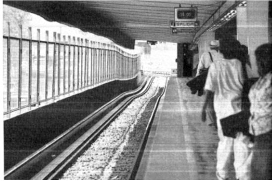
Figura 30. Vista interior de las vías.
