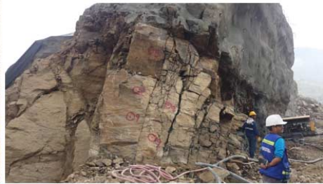
Figura 9. Desprendimiento de bloques en la pared occidental.
