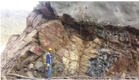
Figura 9. Desprendimiento de bloques en la pared occidental.
