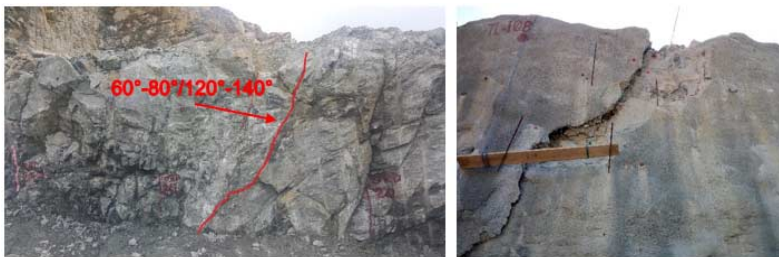
Figura 13. Fracturamiento después de la voladura.
