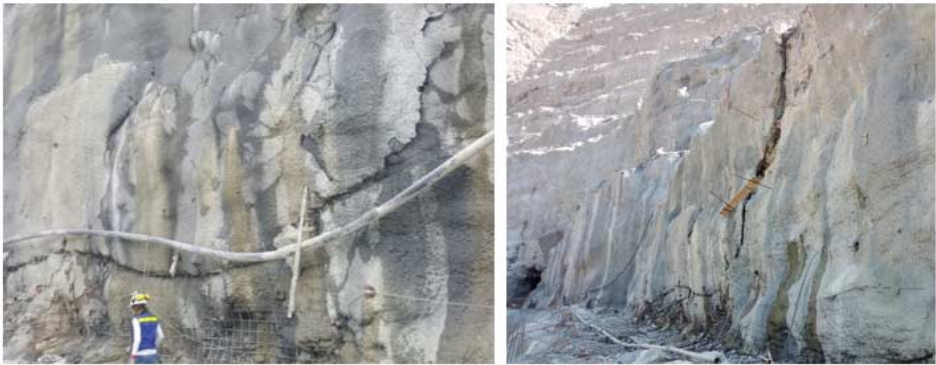
Figura 11. Talud de inicio del cuenco del Vertedero.
