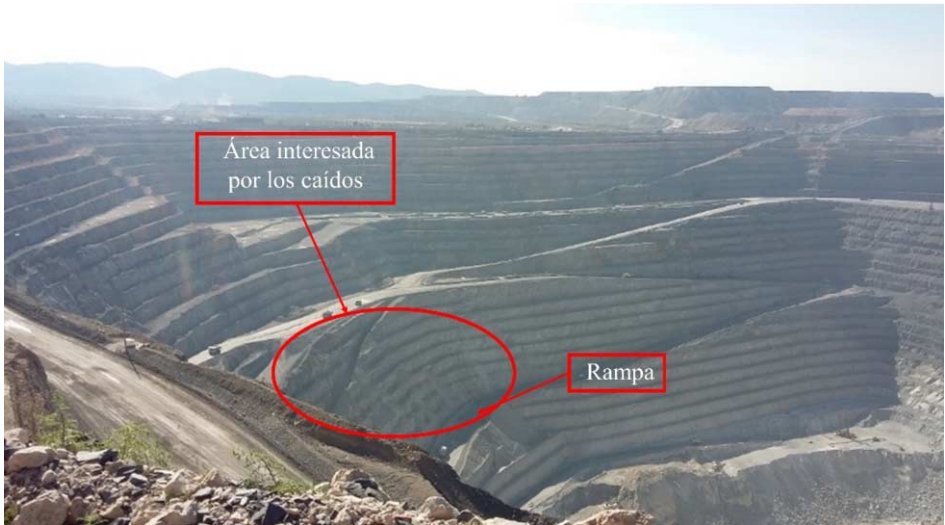
Figura 6. Ubicación del área afectada o de la rampa principal.
